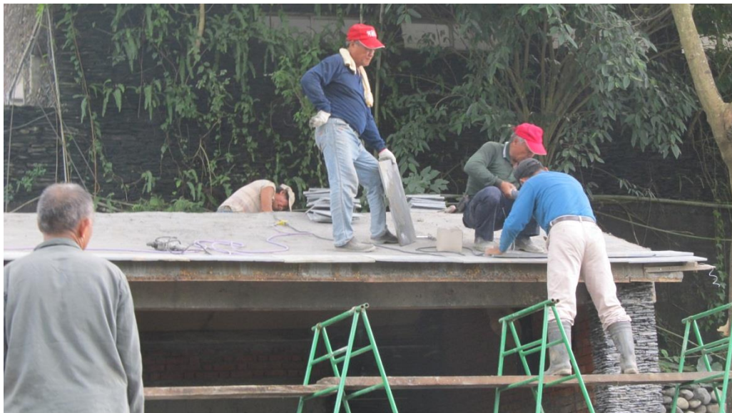
成果說明：實施工作者用工具貼石板(一)圖
