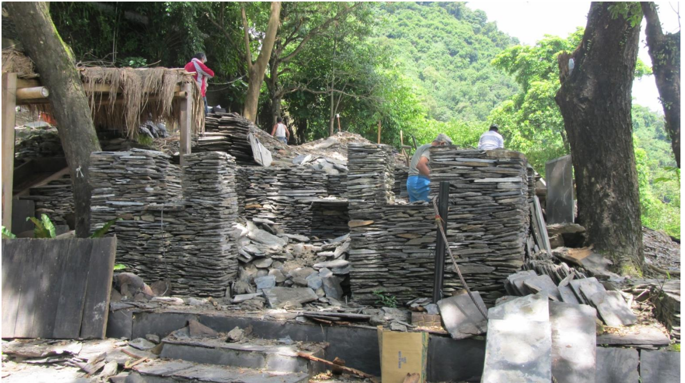
成果說明：::祭師拆除祖靈屋(一)
