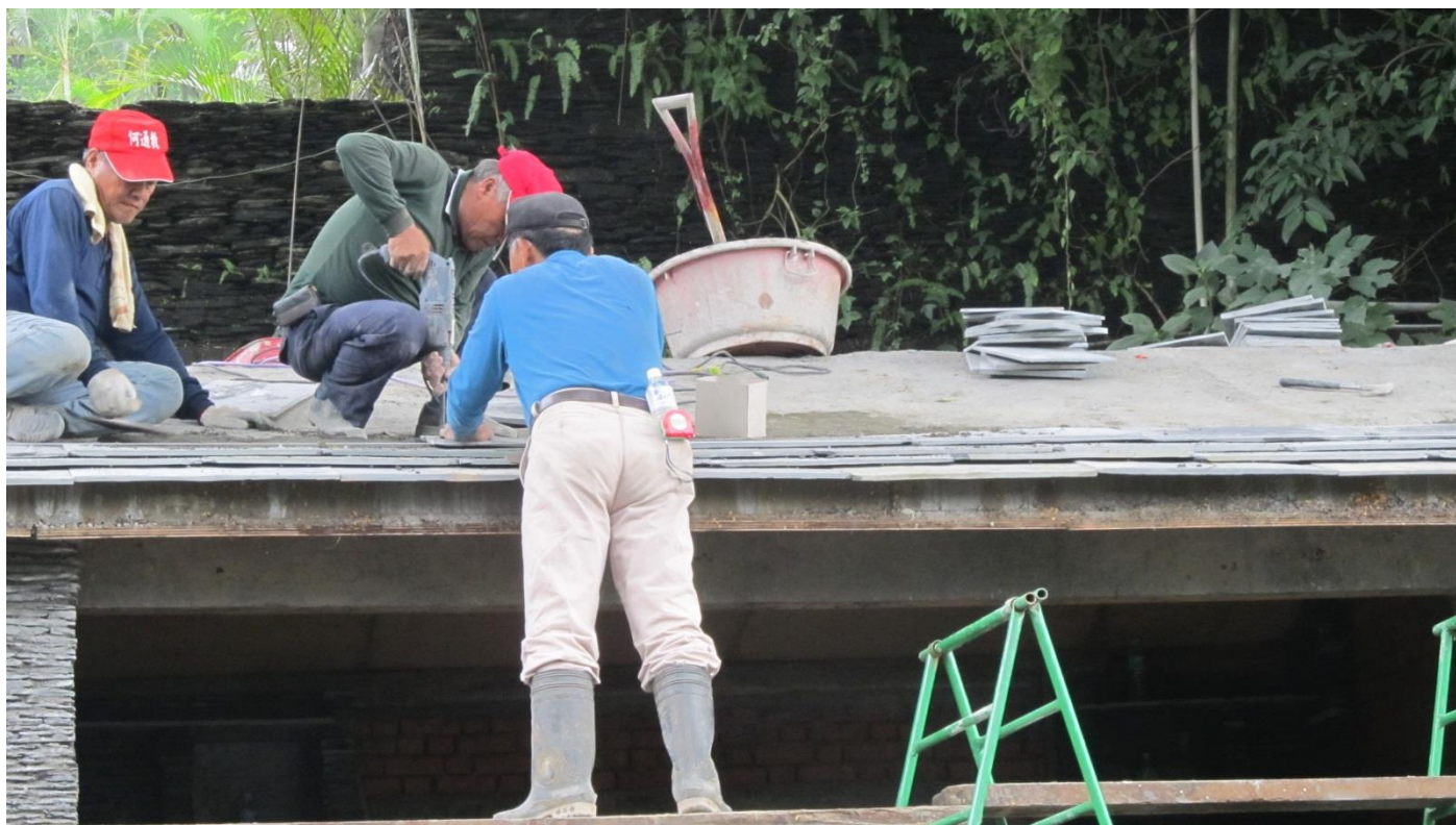
成果說明：實施工作者用工具貼石板(三)圖
