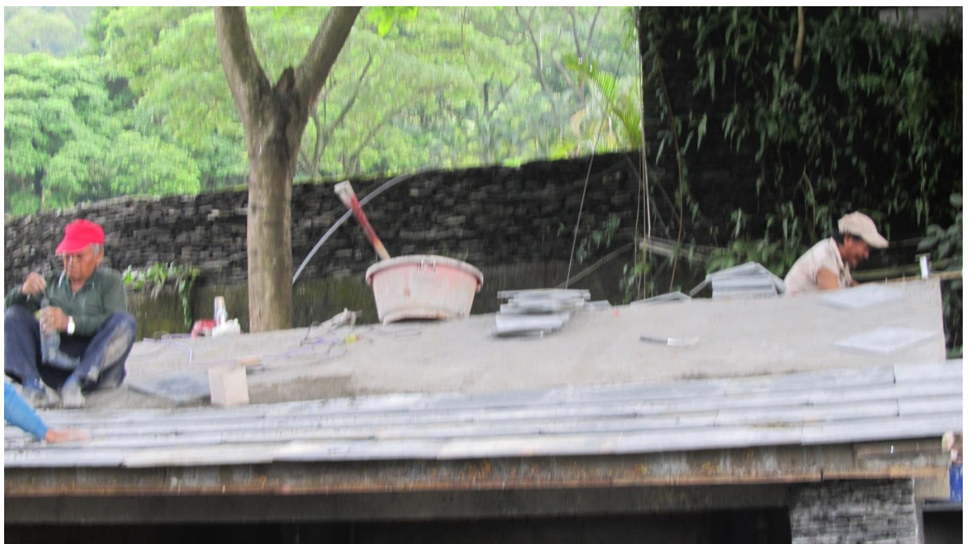
成果說明：實施工作者用工具貼石板(一)圖
