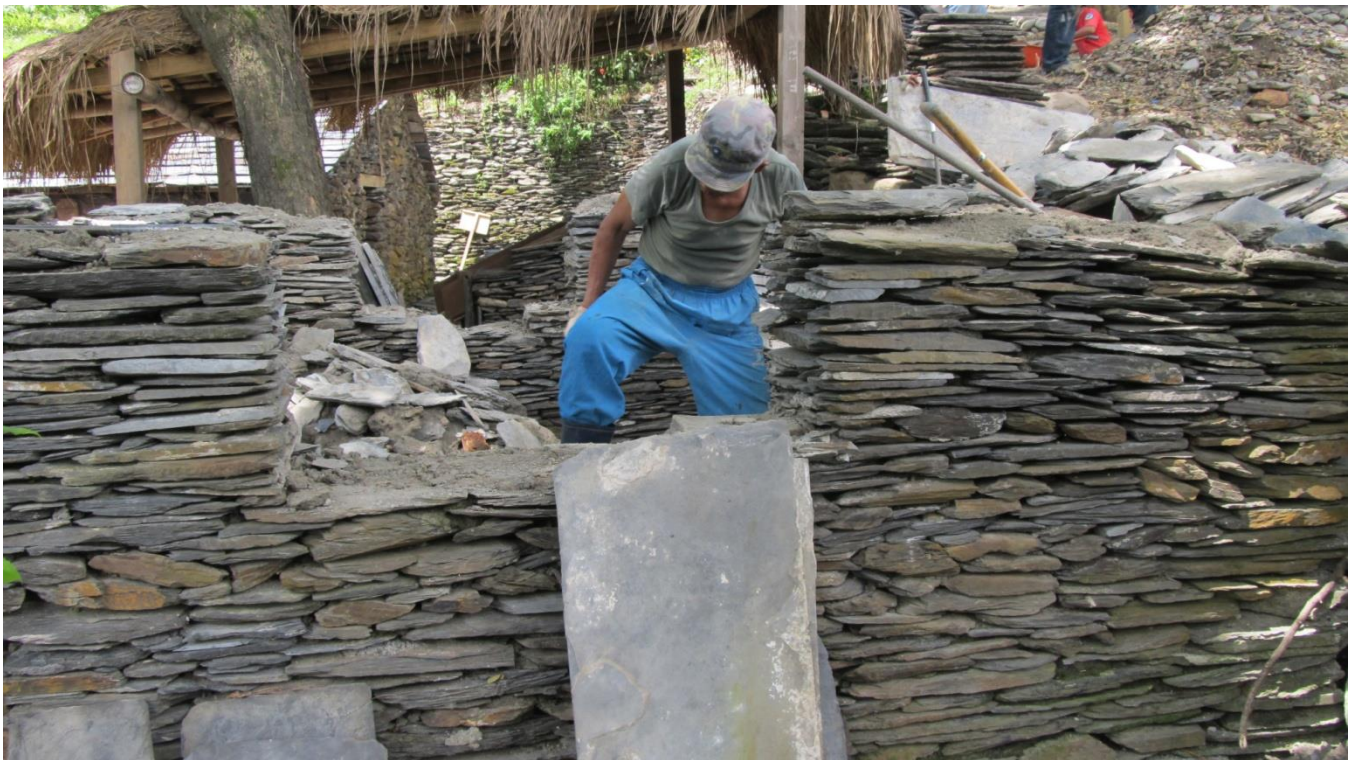
成果說明：祭師拆除祖靈屋(二)
